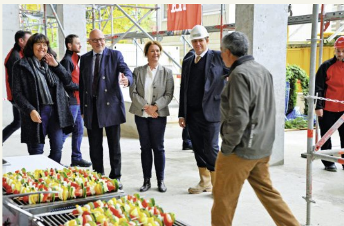
Dr. Silke Lüder, stellvertretende Vorsitzende der Vertreterversammlung (VV) der KVH, Dr. Dirk Heinrich, Vorsitzender der VV der KVH, Catharina Schindel und Olaf Schindel vom Architektenbüro, zuständig für Bauleitung und Projektsteuerung
